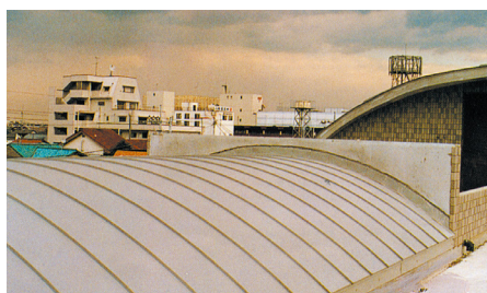
カラーステンレス0.4 マンション4階屋上写真
