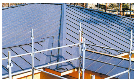
一般住宅嵌合立平葺現場写真
