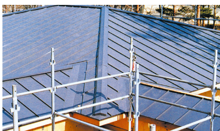
一般住宅嵌合立平葺現場写真
